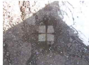
515 k4239 既設コンクリート杭
