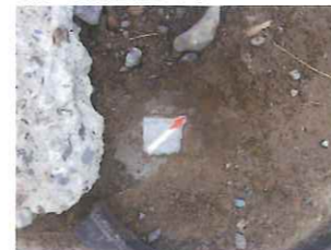
714 既設金属プレート
